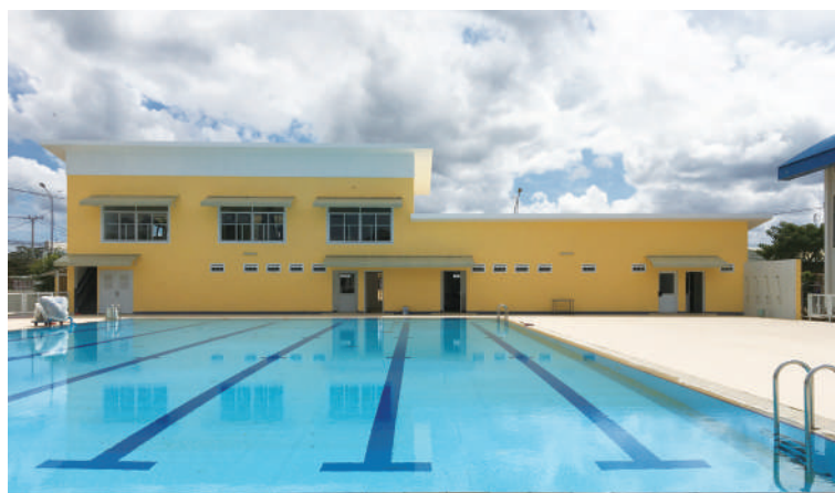
プール周辺のテラス、建物（1階はシャワールーム、2階はジムルーム）
