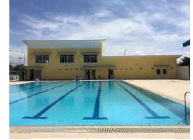
完成したプール周辺の建物
