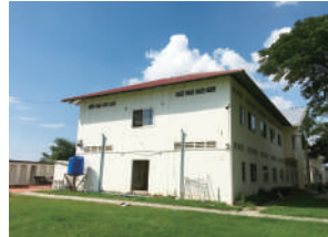
5 月 31 日、学生寮の新屋根構造設置工事完了
