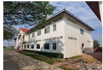
改修が完了した NIPES 学生寮
